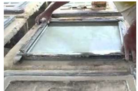
Figura 23. Elaboración de placa de yeso.
