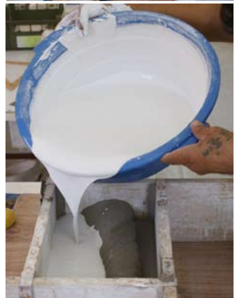
Figura 37 y 38. Hay que sostener firmemente las tiras de madera que servirán de tope a la hora de cubrir con yeso el relieve.
